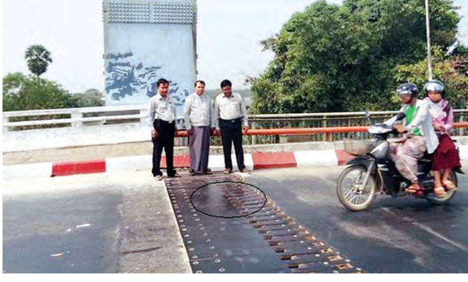
ဦးစီးဌာန ဦးအေးထွန်းမော်တို့ ဦးဆောင်သော ကျွမ်းကျင် ပညာရှင်များက အချိန်နှင့်တစ်ပြေးညီ နေ့ညမပြတ် ပြုပြင်ဆောင်ရွက်မှုကြောင့် ဖေဖော်ဝါရီ ၁၅ ရက် နံနက် ၉ နာရီတွင် Expansion Joint လေးလက်မခန့်
