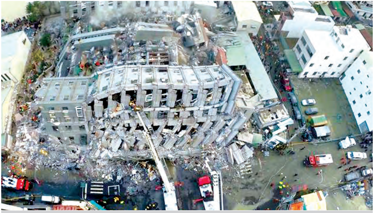
ငလျင်လှုပ်၍ ပြိုကျသွားသည့် အဆောက်အအုံတွင် ကယ်ဆယ်ရေးလုပ်ငန်းများဆောင်ရွက်နေမှုကို ဝေဟင်မှ မြင်ရစဉ်။
