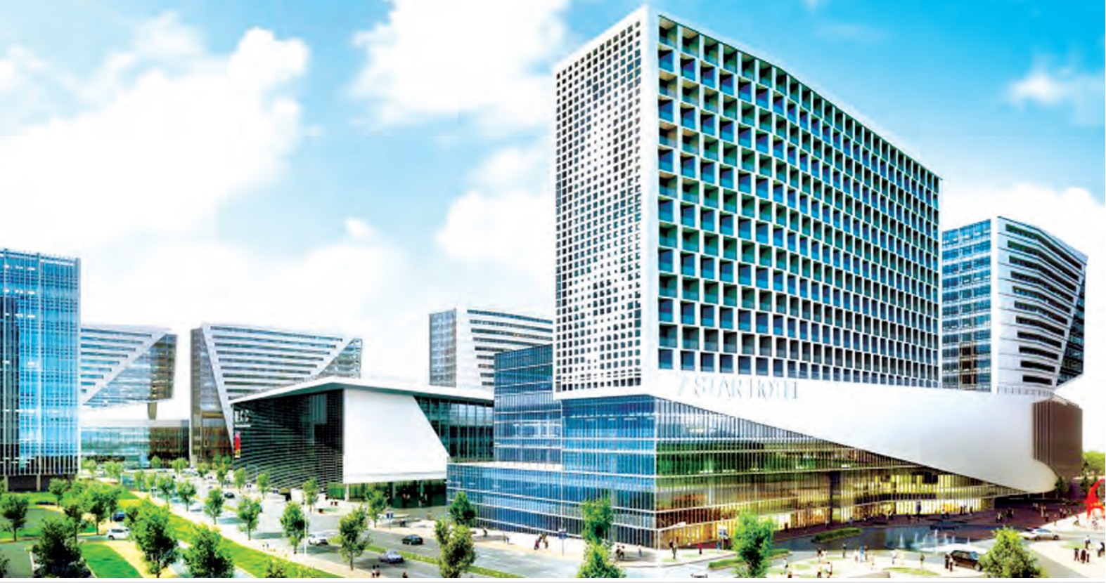
နောင်ဖြစ်ပေါ်လာမည့် ရန်ကုန်မြို့အပြည်ပြည်ဆိုင်ရာ ဒုတိယစီးပွားရေးဇုန် ပုံစံကို တွေ့ရစဉ်။ (သတင်း၊ စာမျက်နှာ-၉) ဓာတ်ပုံ-မျိုးမင်းသိန်း(မရမ်းကုန်း)
