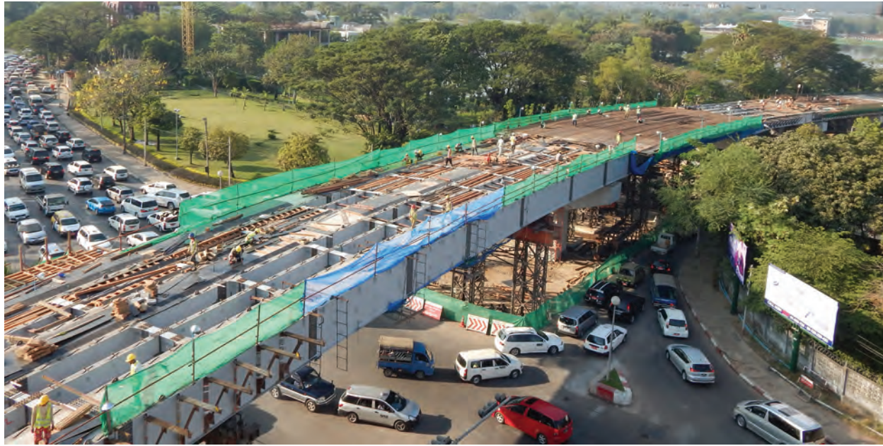
တည်ဆောက်ပြီးစီးတော့မည့် ကုက္ကိုင်းလမ်းဆုံခုံးကျော်တံတားသစ် စီမံကိန်းအားတွေ့ရစဉ်။
