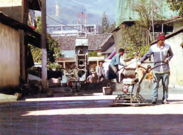
မိုးမောက်မြို့နယ် လွယ်ဂျယ်မြို့ အောင်ချမ်းသာရပ်ကွက်ရှိ အမှတ်(၁၇) လမ်းမကို နိုဝင်ဘာ ၁၃ ရက်က ကွန်ကရစ်လမ်းသစ်ခင်းဆောင်ရွက်နေမှုကို တွေ့ရစဉ်။ (အဆိုပါလမ်းမှာ အရှည်ပေ ၉၀၀၊ အကျယ်ပေ ၂၀ ရှိပြီး ငွေကျပ်သိန်း ၄၀၀ ကုန်ကျမည်ဖြစ်ရာ ရပ်ကွက်အုပ်ချုပ်ရေးမှူး ဦးဆောင်၍ ရပ်မိရပ်ဖနှင့်အလှူရှင်များ ကိုယ့်အားကိုယ်ကိုး စုပေါင်းလှူဒါန်းခဲ့ကြခြင်းဖြစ်ကြောင်း သိရသည်။) ရင်ငြိမ်းပန်း(လွယ်ဂျယ်)
