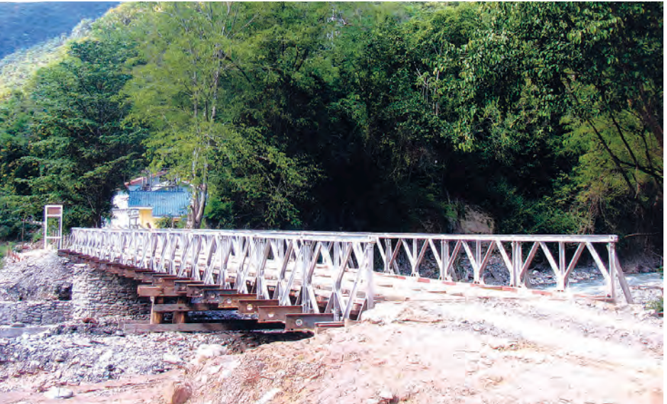
မိုးရွာစဉ်က ရေတိုက်စားမျောပါသွားသည့် ငဆစ်ဗားတံတားနေရာ၌ ယာယီဘေလီတံတား တည်ဆောက်ထားစဉ်။
