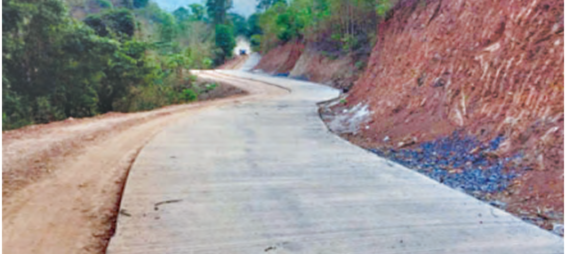
ကယားပြည်နယ် ဖရူဆိုမြို့နယ် နန်းဖဲ-တော်ခူ-ကောကောလမ်း (၄/၂)မိုင် ကွန်ကရစ်လမ်းဖောက်ခြင်းလုပ်ငန်း ဆောင်ရွက်ထားစဉ်။
