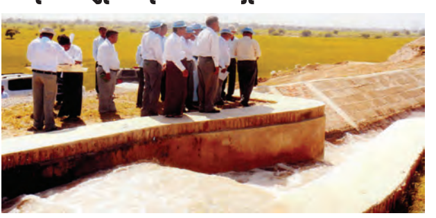
၃၃၀၀၀ ကို ဖြည့်စွက်စိုက်ပျိုးရေးပေးဝေရန်အတွက် Rubber Dam ကို တည်ဆောက်နေခြင်းတို့ကို ကြည့်ရှု စစ်ဆေးသည်။ ဆက်လက်၍ မိတ္ထီလာမြို့နယ် ညောင်ကန်ကျေးရွာအနီးရှိ ရေအရင်းအမြစ် ဦးစီးဌာနက တူးဖော်ခဲ့သော စိုက်ပျိုးရေး စက်ရေတွင်းအမှတ် (မထ-၇၁) သို့ ရောက်ရှိခဲ့ပြီး စိုက်ပျိုးစေ ပိုမိုတိုးတက်စေရေးဆောင်ရွက်ကြရန် မှာကြားခဲ့ကြောင်း သိရသည်။ တင်လှိုင်(မိတ္ထီလာ)
