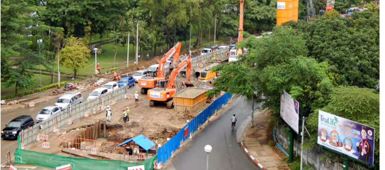
ကုက္ကိုင်းလမ်းဆုံ ခုံးကျော်တံတားစီမံကိန်းဆောင်ရွက်နေမှုကို တွေ့ရစဉ်။
