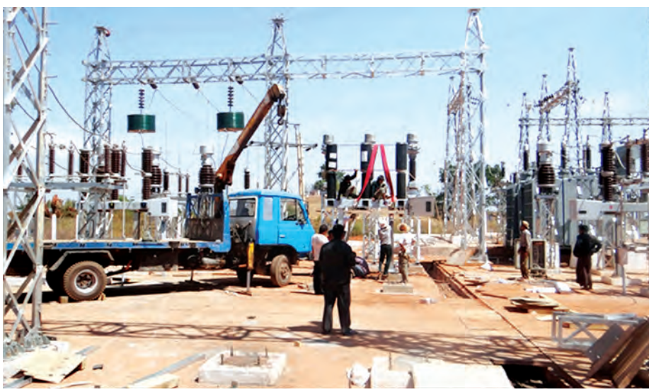
အင်းလေးဒေသဟိုတယ်ဇန် (၂၀)အမ်ပီအေ ၆၆/၁၁ ကေပီဓာတ်အားခွဲရုံ(လျှပ်စစ်ပိုင်းဆိုင်ရာ)တပ်ဆင် တည် ဆောက်နေမှုကို တွေ့ရစဉ်။
