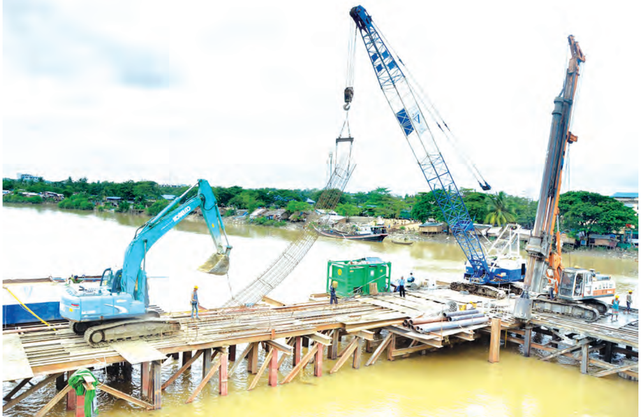
ရန်ကုန်မြို့ မြောက်ဥက္ကလာပနှင့် ဒဂုံမြို့သစ်(မြောက်ပိုင်း)မြို့နယ်တို့ကို ဆက်သွယ်ပေးသည့် ငမိုးရိပ်တံတား(ဗိုလ်ဗထူး) လုပ်ငန်းတည်ဆောက်နေမှုကို တွေ့ရစဉ်။
