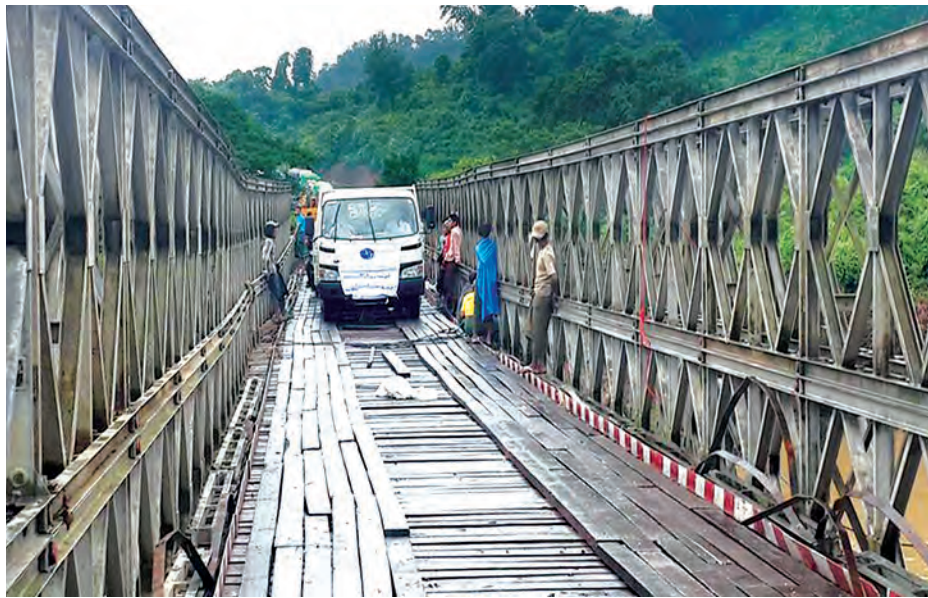
ရခိုင်ပြည်နယ် အမ်း-စစ်တွေလမ်းပေါ်ရှိ ဒါးလက်ချောင်းတံတား ပေ ၉၉၀ ကွေးသွားသောဘောလီကို ပြန်လည် ပြုပြင်ပြီးစီး၍ ယာဉ်များ ဖြတ်သန်းနေသည်ကို တွေ့ရစဉ်။ (ဆောက်လုပ်ရေး)
