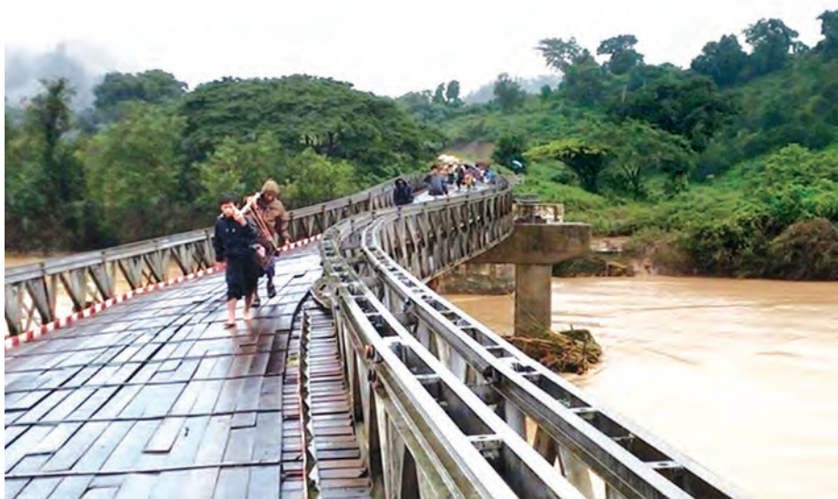
ရခိုင်ပြည်နယ် အမ်း-စစ်တွေလမ်းပေါ်ရှိ ဒါးလက်ချောင်းတံတား ပေ ၉၉၀ P6 ရေလယ်တိုင်ပြုတ်ပါသွား၍ တံတားစောင်းနေသည်ကို တွေ့ရစဉ်။ (ဆောက်လုပ်ရေး)
