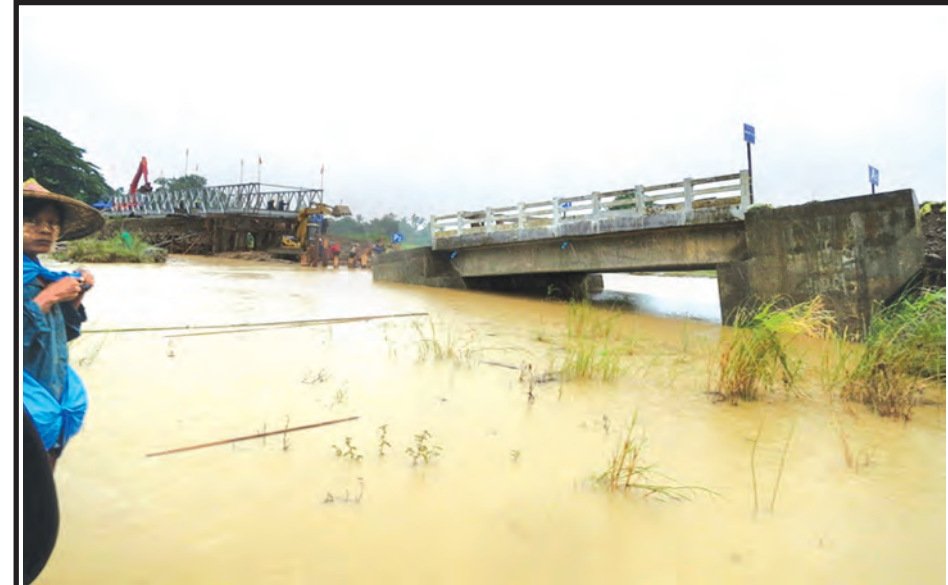
သံတွဲ-ရွှေလမ်းမိုင် (၂၆/၇-၂၇/၀) ကြား တံတားအမှတ်(၁၀/၂၇) အရှည်ပေ ၄၀ တံတားနိမ့်ကျ၍ ချဉ်းကပ် လမ်းပြတ်ပါသွားခဲ့သည်ကို တွေ့ရစဉ်။ (ဆောက်လုပ်ရေး)
