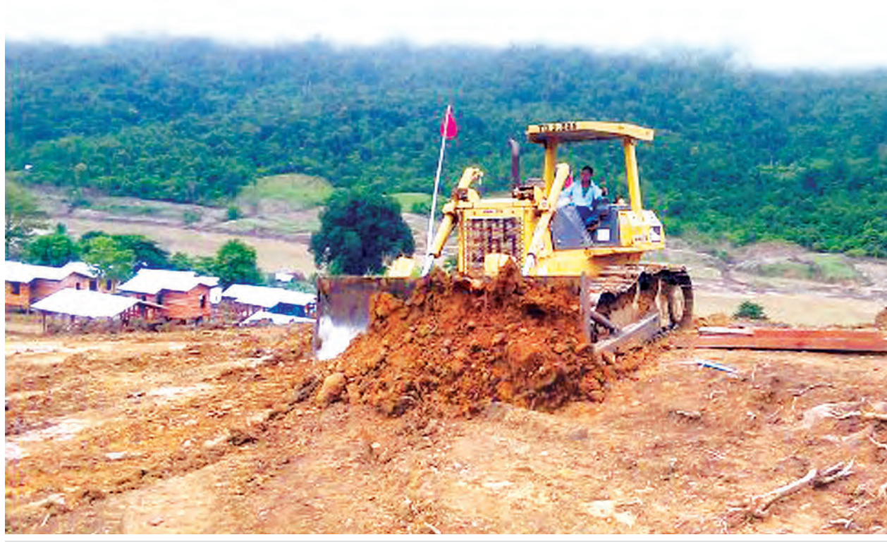
အောက်တိုဘာ ၅ ရက်က စစ်ကိုင်းတိုင်းဒေသကြီး ကလေးမြို့နယ် ကျောက္ကာကျေးရွာသစ်၌ စက်ယန္တရားများအသုံးပြု၍ လမ်းဖော်ပေးနေသည်ကို တွေ့ရစဉ်။
