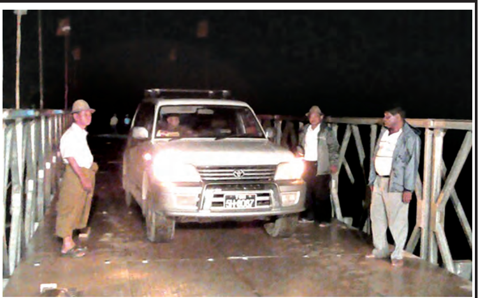
သံတွဲ-ရွှေလမ်း မိုင် (၂၆/၇-၂၇/၀) ကြား တံတားအမှတ်(၁၀/၂၇) အရှည်ပေ ၁၄၀ တစ်လွှာတစ်ထပ် ဘောလီတံတားကို ပြုပြင်ဆောင်ရွက်ပြီးနောက် မော်တော်ယာဉ်ဖြတ်သန်းသွားလာစဉ်။ (ဆောက်လုပ်ရေး)
