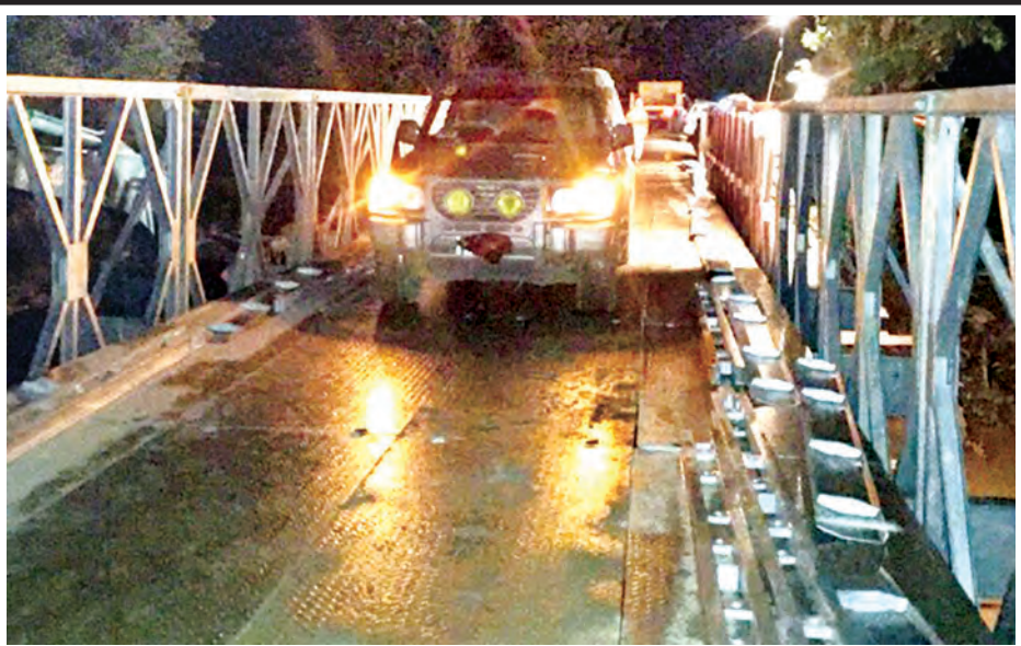
သံတွဲ-ဂွလမ်းမိုင် (၂၆/၆-၂၆/၇) ကြား တံတားအမှတ် (၈/၂၇) အရှည်ပေ ၁၁၀ ရှိ ဘေးလိတ်တားဆောင်ရွက် ပြီး၍ ယာဉ်များ ဖြတ်သန်းနေသည်ကို တွေ့ရစဉ်။
