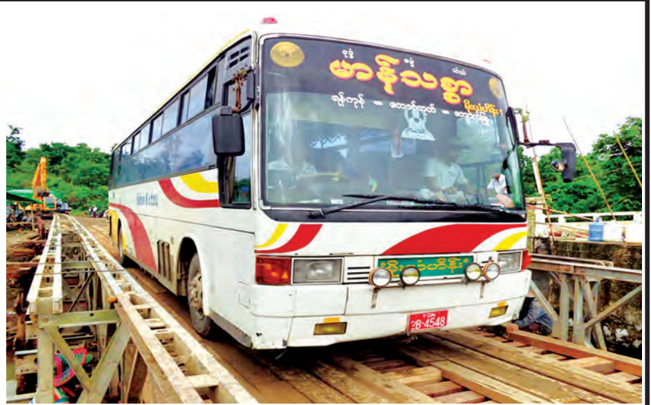
ရန်ကုန်-ကျောက်ဖြူလမ်း (တောင်ကုတ်-မအီအပိုင်း) ၎င်းပျောချောင်းတံတား (၂/၁၅) ပေ ၁၂၀ ယာယီဘေလီတည်ဆောက်ပြီးစီး၍ မော်တော်ယာဉ်များ သွားလာနေသည်ကို တွေ့ရစဉ်။ (ဆောက်လုပ်ရေး)
