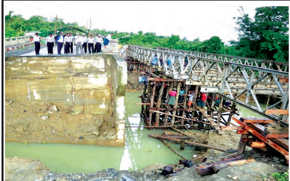
ရန်ကုန်-ကျောက်ဖြူလမ်း (တောင်ကုတ်-မအီအပိုင်း) ၎င်းပျောချောင်းတံတား (၂/၁၅) ပေ ၁၂၀ ဘေလီထိုးနေသည်ကို တွေ့ရစဉ်။ (ဆောက်လုပ်ရေး)
