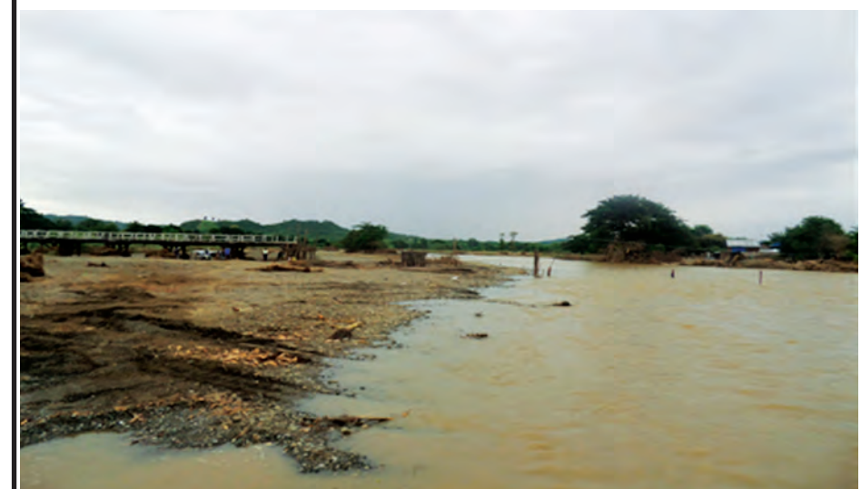
မကွေးတိုင်းဒေသကြီး ငမဲ-စေတုတ္ထရာလမ်းပေါ်ရှိ မန်းချောင်းတံတား ပေ ၄၅၀ (သစ်သား၊ ဘောလီ) ပေ ၁၅၀ အရှည်ခန့် ရေတိုက်စားမျောပါပြီးနောက် တွေ့ရစဉ်။ (ဆောက်လုပ်ရေး)
