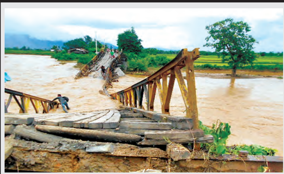
တမူး-စေတီလမ်း မိုင် ၁၈/၀-၁၈/၁ ကြား တံတားအမှတ်(၁/၁၉) နန်းတီဆင်းတံတား ပေ ၁၆၀ တံတားအလယ်မှ ခါးညွတ်၍ ကျိုးကျပျက်စီးသွားသည်ကို တွေ့ရစဉ်။ (ဆောက်လုပ်ရေး)
