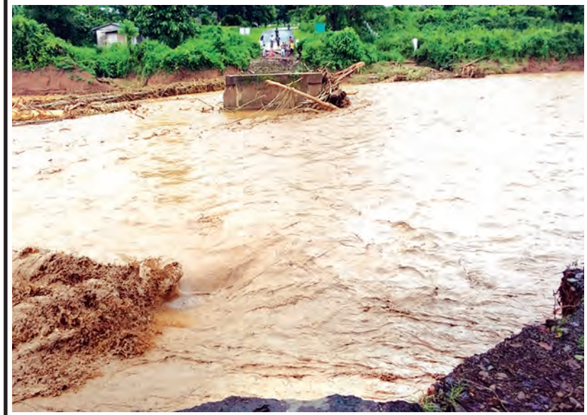
ကလေး-ကျီကုန်း-တမူးလမ်း မိုင် (၇၃/၅-၇၃/၆) ကြားရှိ တီးတိန်ယံတံတား (၁/၇၄) ပေ ၁၉၀ ရေတိုက် စားပျက်စီးနေပုံ။
