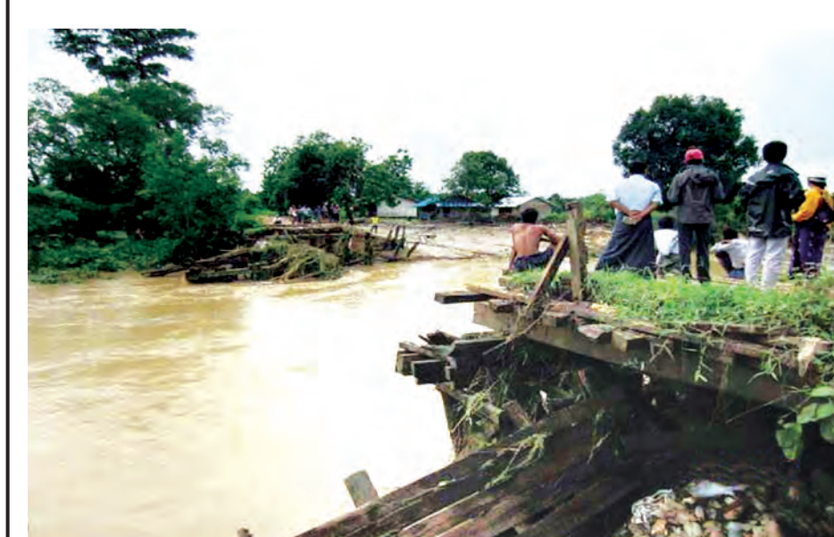
မန္တလေး-တကောင်း- ဗန်းမော်လမ်းပေါ်ရှိ ဟင်္သာချောင်းတံတား (၃/၇၈) ပေ (၆၀) နှစ်လွှာတစ်ထပ်ဘေလီ ရေတိုက်စားပျက်စီးနေမှုကို တွေ့ရစဉ်။ (ဆောက်လုပ်ရေး)
