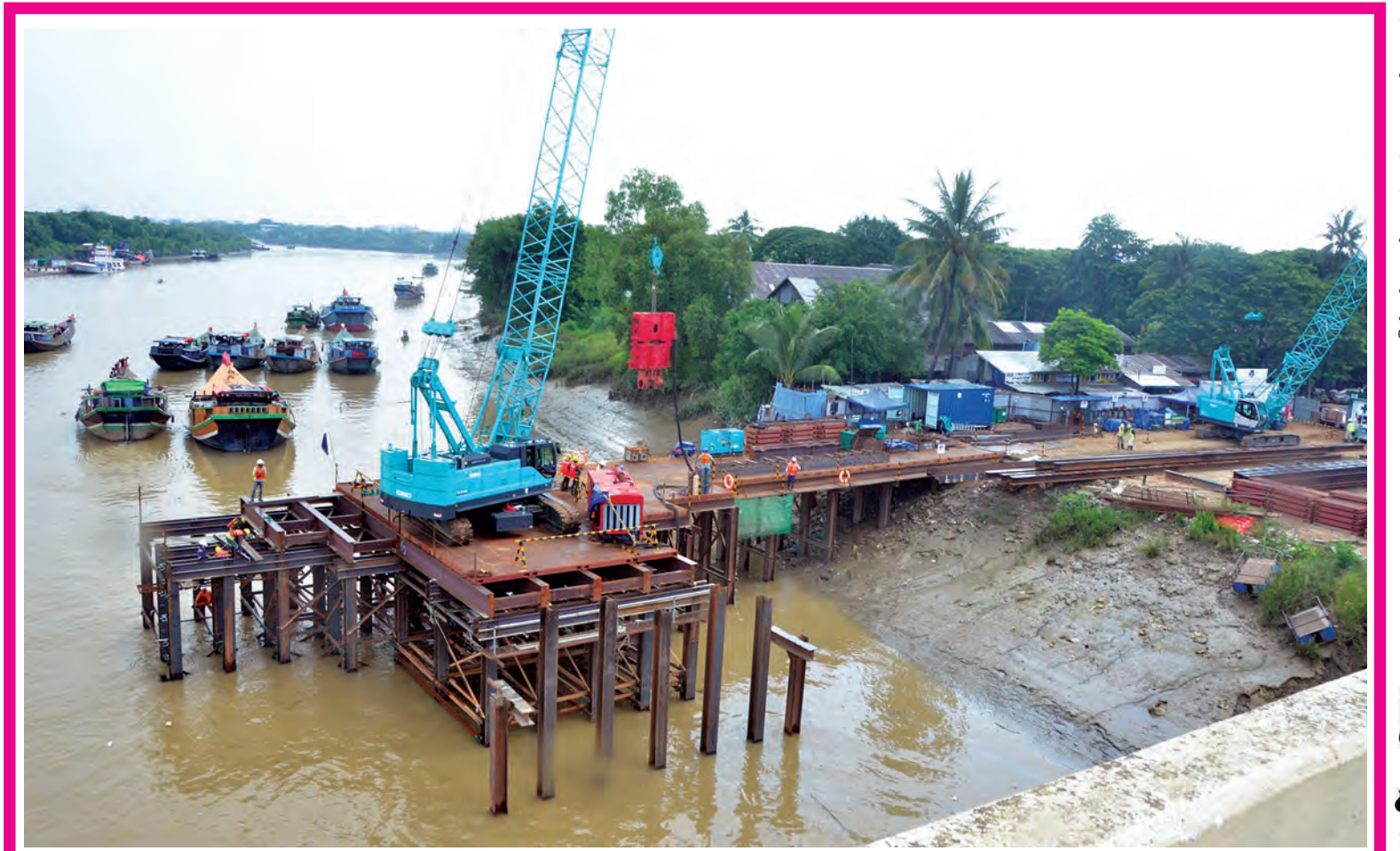
ရန်ကုန်တိုင်းဒေသကြီး မင်္ဂလာတောင်ညွန့်နှင့် ဒေါပုံမြို့နယ်တို့ကို ဆက်သွယ်ပေးမည့် သာကေတတံတားသစ် တည်ဆောက်နေမှုကို စက်တင်ဘာ ၂၈ ရက်က တွေ့ရစဉ်။ ဓာတ်ပုံ-တင်စိုး(မြန်မာ့အလင်း)
