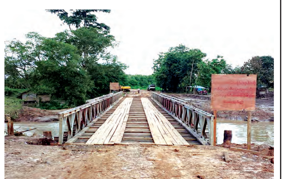
မန္တလေး-တကောင်း- ဗန်းမော်လမ်းပေါ်ရှိ ဟင်္သာချောင်းတံတား (၃/၇၈) ပေ (၁၄၀) ဘေလီတံတား ပြုပြင်ဆောင်ရွက်ပြီး တွေ့ရစဉ်။ (ဆောက်လုပ်ရေး)
