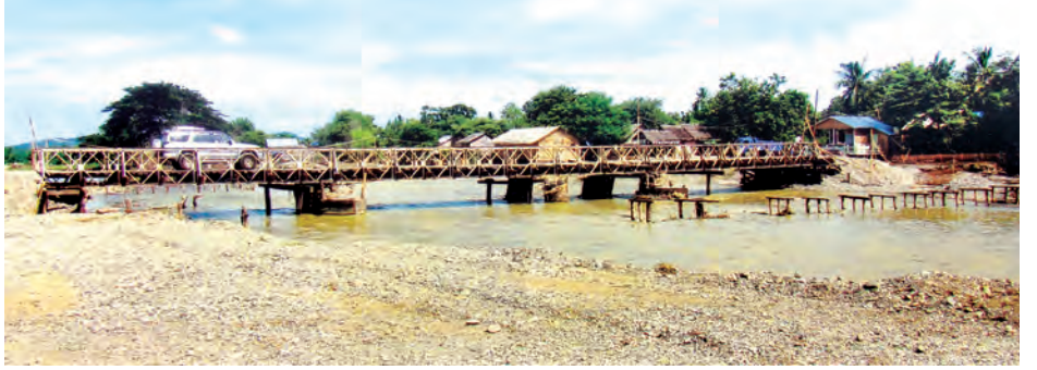
မကွေးတိုင်းဒေသကြီး ငမံနှင့် စေတုတ္ထရာကားလမ်းပေါ်ရှိ ရေကြီး ရေလျှံစဉ်က မျောပါသွားခဲ့သော မန်းချောင်းမြူးတံတား နေရာတွင် အလျားပေ ၁၅၀ ရှိ ယာယီ ဘေလီတံတားကို အမှတ် (၃) တံတားအထူးအဖွဲ့က တည်ဆောက်ပေးထား၍ ကားများဖြတ်သန်း မောင်းနှင်လျက်ရှိသည်ကို တွေ့ရစဉ်။ ခရမ်းစိုးမြင့်
