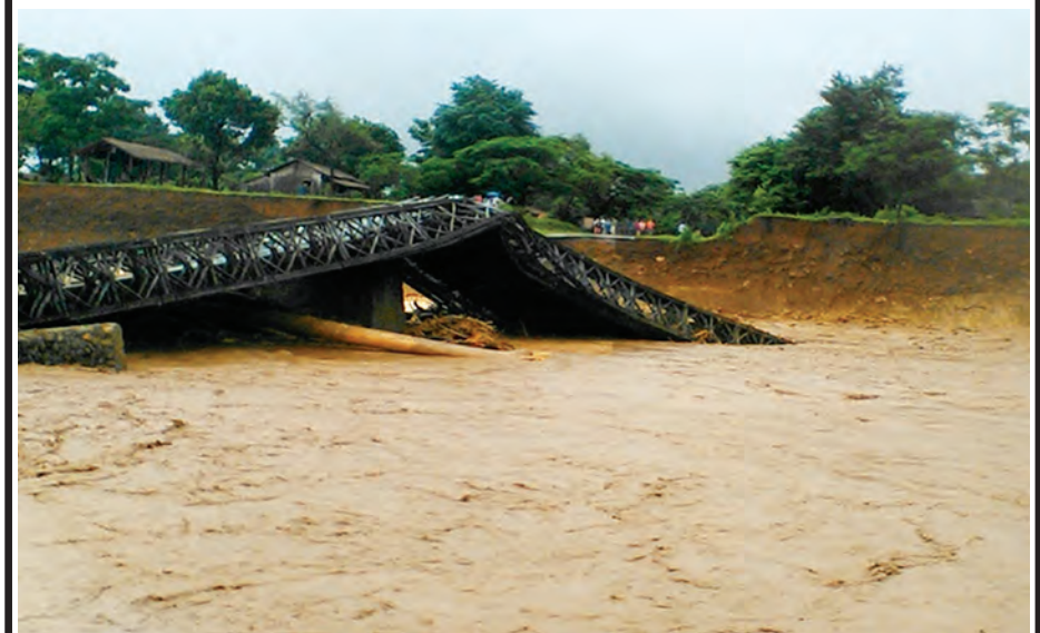
ကလေး-ကျီကုန်း-တမူးလမ်း မိုင် (၇၁/၂-၇၃/၃)ကြားရှိ တို့ဗန်တံတား (၃/၇၂) ပေ ၂၁၀ ဘေးလိတ်တား ရေတိုက်စားနေပုံ။ (ဆောက်လုပ်ရေး)
