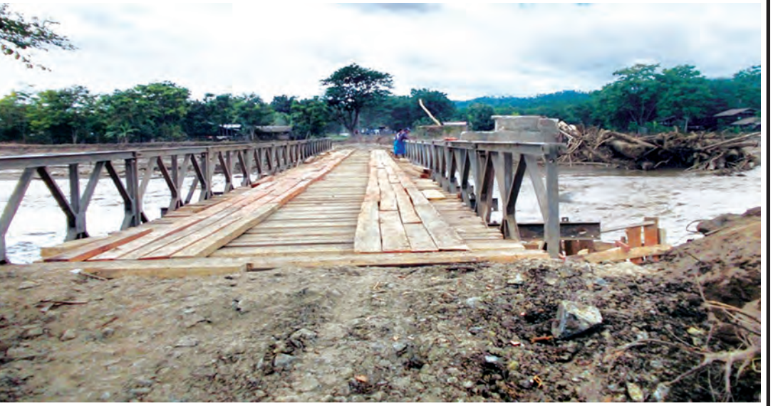
ကလေး-ကျီကုန်း-တမူးလမ်း မိုင် ၆၁/၆-၆၁/၇ ကြားရှိ ကမ္မကြီးတံတား (၄/၆၂) ပေ (၃၁၀) ဆောင်ရွက် ပြီးစီးနေပုံကို တွေ့ရစဉ်။ (ဆောက်လုပ်ရေး)
