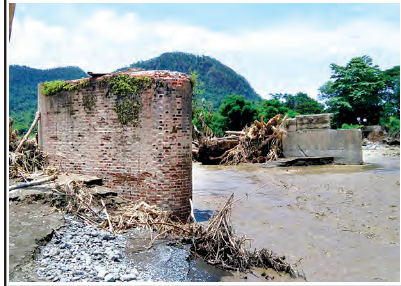
ကလေး-ကျီကုန်း-တမူးလမ်း မိုင် ၆၁/၆-၆၁/၇ ကြားရှိ ကမ္မကြီးတံတား (၄/၆၂) ပေ (၃၁၀) ဘာလီ ဖြတ်ပါသွားပြီးနောက် တွေ့ရစဉ်။ (ဆောက်လုပ်ရေး)
