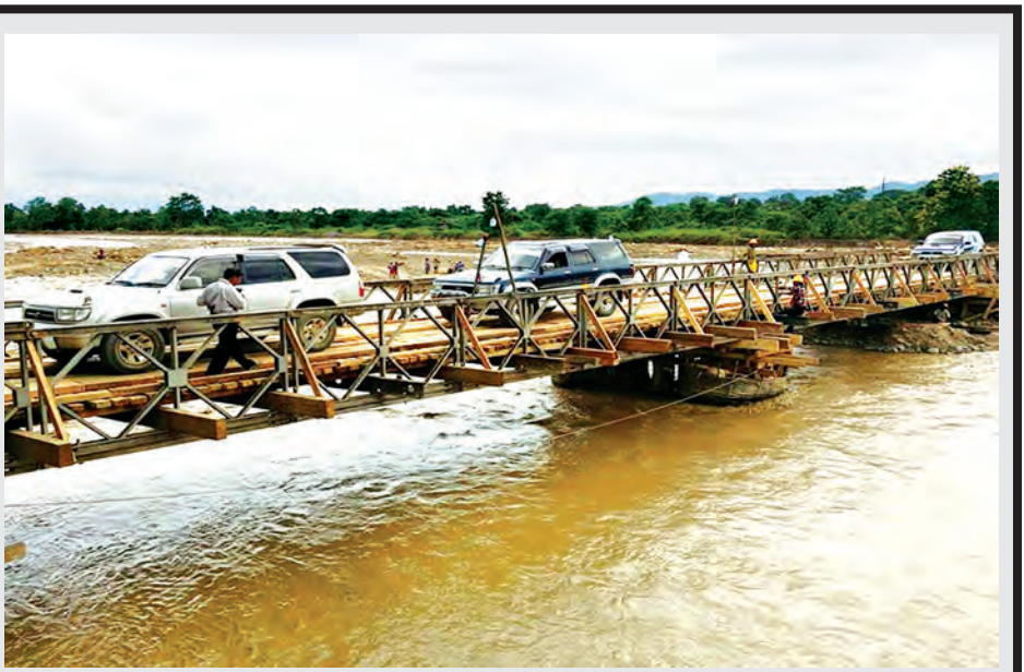
ကလေးဝ-ကျီကုန်း-တမူးလမ်း မိုင် ၅၉/၀-၅၉/၁ ကြားရှိ ကနန်တံတား(၁/၆၀)၏ ပေ ၁၀၀ ဘေလီထိုးပြီး ယာဉ်များဖြတ်သန်းနေသည်ကို တွေ့ရစဉ်။ (ဆောက်လုပ်ရေး)
