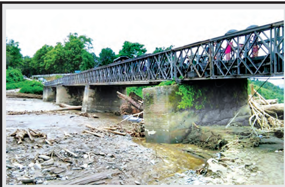
ကလေးဝ-ကျီကုန်း-တမူးလမ်း မိုင် ၅၉/၀-၅၉/၁ ကြားရှိ ကနန်တံတား(၁/၆၀)ပေ ၂၉၀ ဘေလီတံတား ရေလယ်တိုင်များ နိမ့်စောင်းနေသည်ကို တွေ့ရစဉ်။ (ဆောက်လုပ်ရေး)
