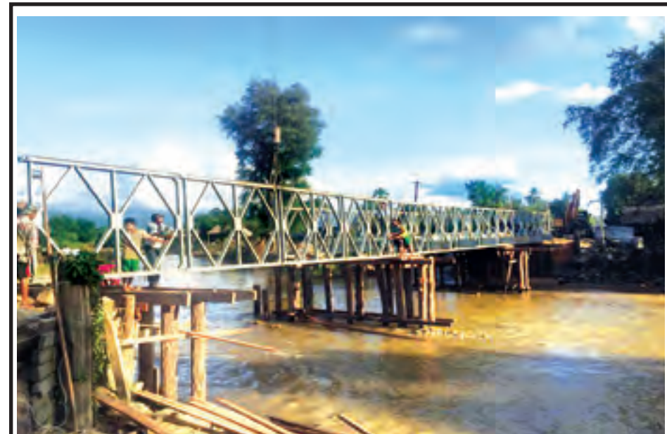
ရွှေဘို-မြစ်ကြီးနားလမ်းပေါ်ရှိ ဟဲနုတ်တား ပေ ၁၀၀ နှစ်လွှာတစ်ထပ်ဘေးလီတံတား ပြင်ဆင်နေမှုကို တွေ့ရစဉ်။ (ဓာတ်ပုံ-ဆောက်လုပ်ရေး)
