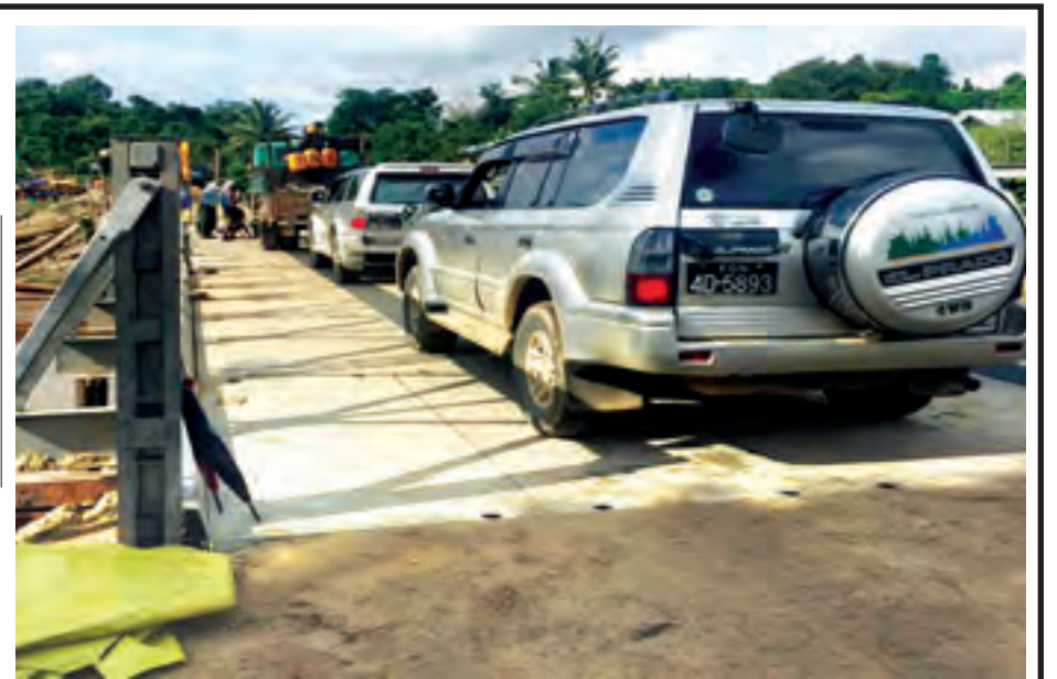
ရွှေဘို-မြစ်ကြီးနားလမ်းပေါ်ရှိ ဟဲနုတ်တား ပေ ၁၀၀ နှစ်လွှာတစ်ထပ်ဘေးလီတံတား ဆောင်ရွက်ပြီးစီးမှုကို တွေ့ရစဉ်။ (ဓာတ်ပုံ-ဆောက်လုပ်ရေး)
