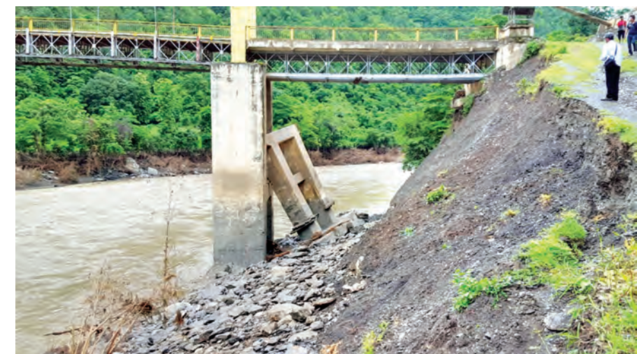
တီးတိန်-ရိဒ်လမ်းပေါ်ရှိ မံဆောင်းကြိုးတံတား ပေ ၃၆၀ ရိဒ်ဘက်ကမ်းချဉ်းကပ်တံတားတိုင် လဲကျပျက်စီးနေစဉ်။ (ဆောက်လုပ်ရေး)
