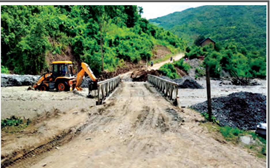
တီးတိန်-တွန်းဇံ-ကျိခါးလမ်းပေါ်ရှိ ဗျဲလ်ကျင်းတံတား ပေ (၇၀) ပြန်လည်ပြုပြင်ပြီးစီးပုံ။ (ဆောက်လုပ်ရေး)
