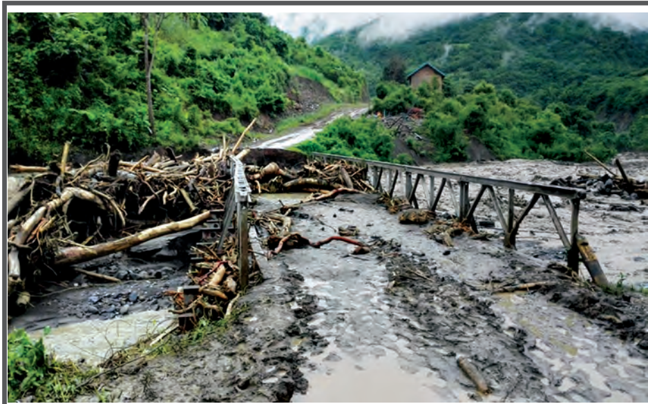
တီးတိန်-တွန်းဇံ-ကျိခါးလမ်းပေါ်ရှိ ဗျဲလ်ကျင်းတံတား ပေ (၇၀)ဘာလီတံတားပျက်စီးနေပုံ။ (ဆောက်လုပ်ရေး)
