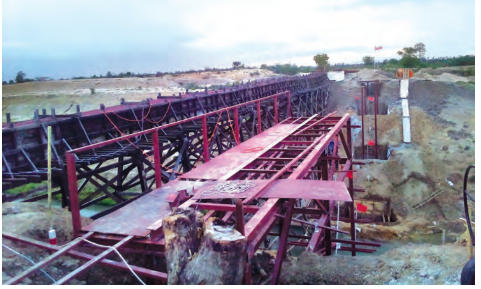
ရေတံခံနိုင်ရည်အားနည်း၍ စိုက်ပျိုးရေးလိုလောက်စွာ မရရှိသော်လည်း ခိုင်ခံ့သည့် စတီးလ်ရေတံလျှောက် ဆောက်လုပ်ပြီးစီးသွားပါက စိုက်ပျိုးရေးကို ဆည်ရေလိုလောက်စွာ ပေးနိုင်တော့မည်ဖြစ်ကြောင်း စလင်းမြို့နယ် မရရှိသော်လည်း ခိုင်ခံ့သည့် စတီးလ်ရေတံလျှောက် ဆောက်လုပ်ပြီးစီးသွားပါက စိုက်ပျိုးရေးကို ဆည်ရေ
