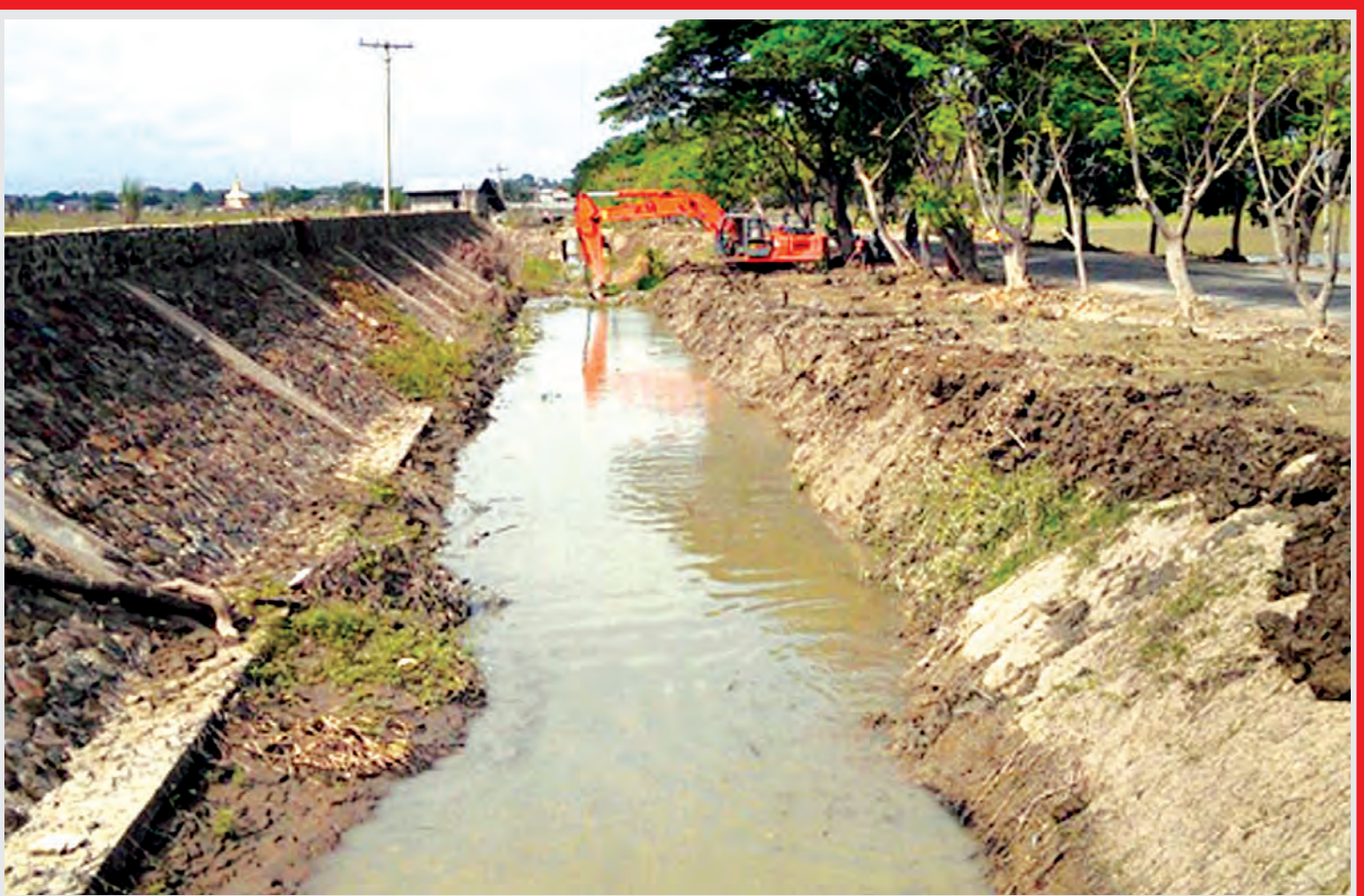
ကလေးဒေသမြန်မာပြည်ထောင်စုရေးလုပ်ငန်းများ ဆောင်ရွက်လျက်ရှိရာ စက်တင်ဘာ ၇ ရက်က ကလေး-ကလေးဝလမ်း ရေမြောင်းများ တူးဖော်ခြင်းလုပ်ငန်းများကို ဆည်မြောင်းဦးစီးဌာနမှ ဆောင်ရွက်လျက်ရှိသည်ကို ဤသို့တွေ့ရသည်။
