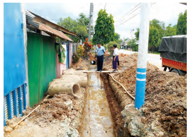
ရမ်းပြည်နယ်(အရှေ့ပိုင်း) တာချီလိတ်မြို့နယ် စည်ပင်သာယာရေး ကော်မတီက ရေစီးရေလာကောင်းမွန်ပြီး မြို့သန့်ရှင်းသာယာလှပရေး ကွန်ကရစ်လမ်းများ၊ ကတ္တရာလမ်းများအဖြစ် တိုးချဲ့ဆောင်ရွက်ခြင်း၊ လမ်းဘေးဝဲယာ အုတ်စီရေနုတ်မြောင်းများ၊ လမ်းဖြတ် ရေနုတ်မြောင်းများ နှင့် ချောင်းကူးတံတားတည်ဆောက်ခြင်းလုပ်ငန်းများကို ဩဂုတ်လ စတုတ္ထပတ်က မြို့နယ်စည်ပင်သာယာရေးကော်မတီဥက္ကဋ္ဌ ဦးစိုင်းကျော်စံ ကွင်းဆင်းစစ်ဆေးစဉ်။ ဝေယံလင်း(ပြန်/ဆက်)
