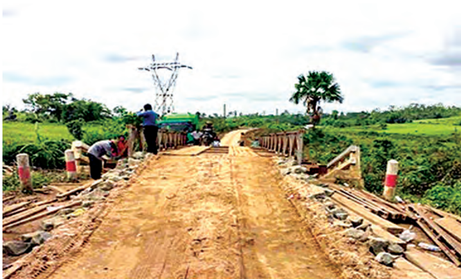
စစ်ကိုင်းတိုင်းဒေသကြီး အတွင်း မန္တလေး-တကောင်း-ဗန်မော်-မြစ်ကြီး နားလမ်းပိုင်း မိုင်တိုင် (၆၉/၂-၆၉/၃) ကြား တံတားအမှတ် (၁/၇၀) ကို ယာယီဘေးလိတ်တားအဖြစ် ဆောင်ရွက် ထားစဉ်။ (အပေါ်ပုံ)
