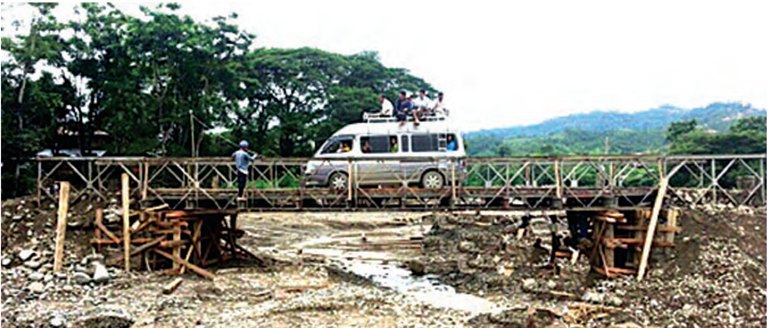
မကွေးတိုင်းဒေသကြီးအတွင်း ဆင်ပေါင်ပဲ-တောညောင်ပင်သာလမ်း၊ မင်းတုန်းချောင်း (ရေနံသာတံတား) သရက်ချဉ်းကပ်လမ်း တာပြတ်တောက်၍ မြေဖိုခြင်းလုပ်ငန်းဆောင်ရွက်စဉ်။
