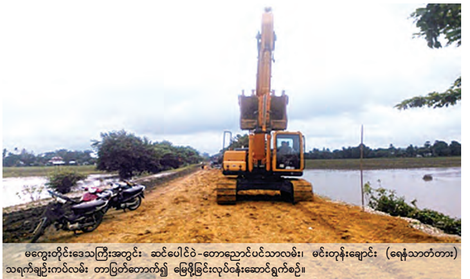
မကွေးတိုင်းဒေသကြီးအတွင်း ဆင်ပေါင်ပဲ-တောညောင်ပင်သာလမ်း၊ မင်းတုန်းချောင်း (ရေနံသာတံတား) သရက်ချဉ်းကပ်လမ်း တာပြတ်တောက်၍ မြေဖိုခြင်းလုပ်ငန်းဆောင်ရွက်စဉ်။
