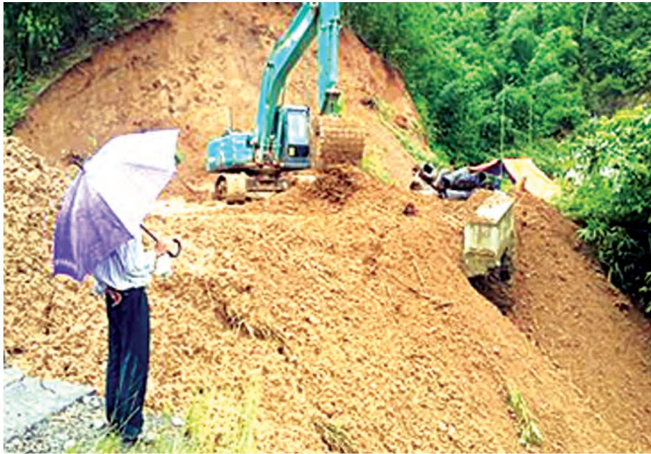
ရခိုင်ပြည်နယ်အတွင်း ရန်ကုန်-စစ်တွေလမ်း အပိုင်း(၁) မိုင်တိုင် (၈/၆-၁၁/၆) အတွင်း (ရွှေမဲတောင်အပိုင်း) မိုင်(၁၀/၂)တွင် တောင်ကျရေဖြတ်သန်းစီးဆင်းမှုကြောင့် ပဲ့ကျပျက်စီးသွားသောလမ်းပိုင်းကို ပြုပြင်နေစဉ်။
