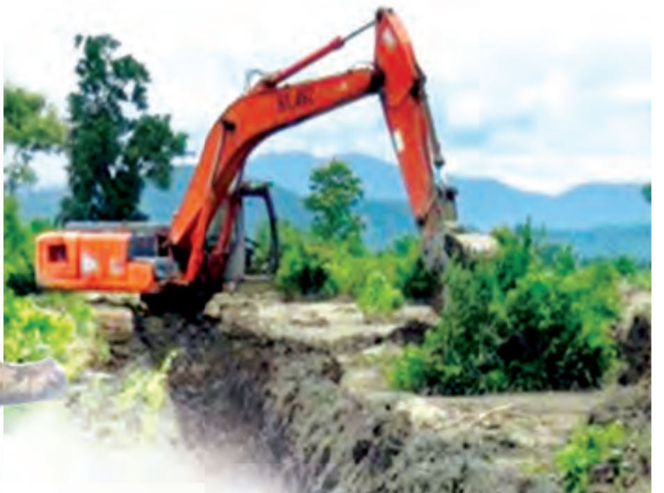
ကလေးမြို့နယ်အတွင်းရှိ သစ်စိမ့်ပင်ရေပေးမြောင်းကို ဆည်မြောင်းဦးစီးဌာနပိုင် စက်ယန္တရားဖြင့် သန့်ရှင်းတူးဖော်နေစဉ်။
