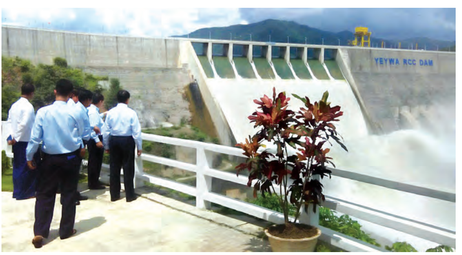
ရဲရွာ ရေလှောင်တံမံသည် Roller Compacted Concrete (RCC) တံမံအမျိုးအစားဖြစ်ပြီး ကန်ရေပြည့် သိုလှောင်ရေပမာဏ ၂၁ ဒသမ ၁၄ သိန်း ဧကပေကို
