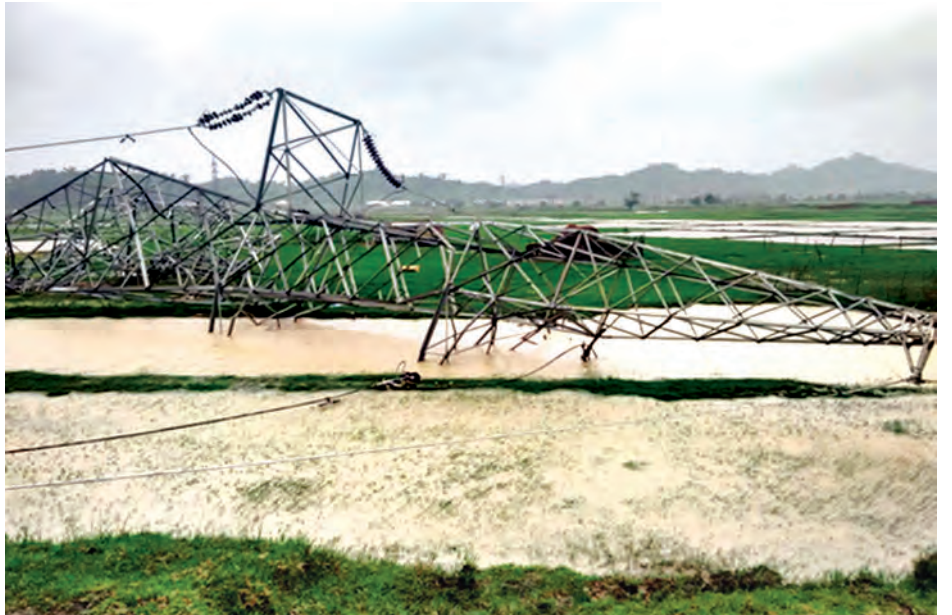
၂၃၀ ကေဗြီ အမ်း-မြောက်ဦး-ပုဏ္ဏားကျွန်း ဓာတ်အားလိုင်း တာဝါတိုင်အမှတ်(MP-96) မိုးသက်လေပြင်းတိုက်ခတ်၍ ပြိုလဲနေသည်ကို တွေ့ရစဉ်။
