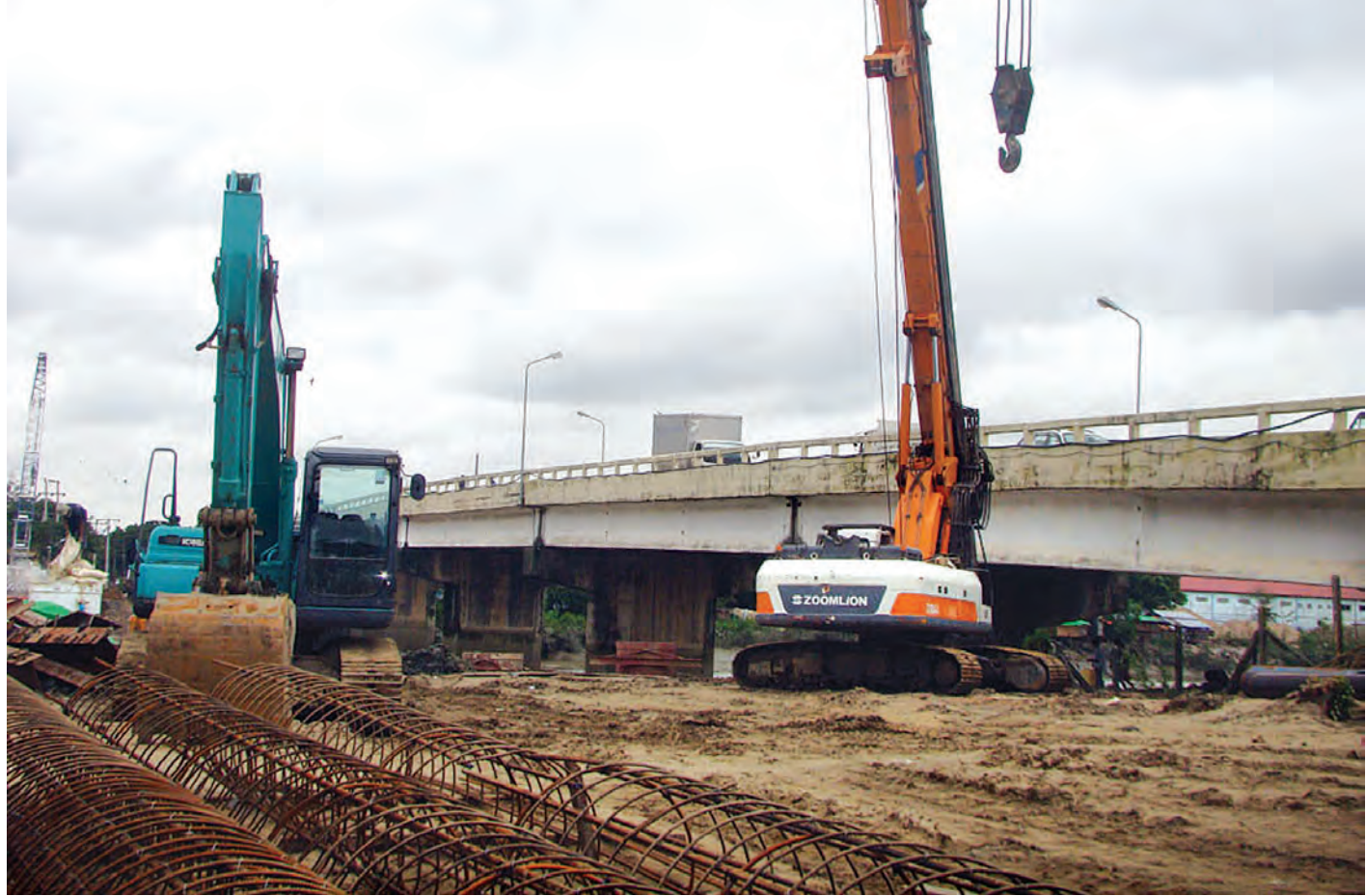
မြောက်ဥက္ကလာပမြို့နယ်နှင့် ဒဂုံမြို့သစ် (မြောက်ပိုင်း)မြို့နယ်နှစ်ခုကို ဆက်သွယ်ပေးမည့် ငမိုးရိပ်တံတား (ဗိုလ်မှူးဗထူး)အသစ်တစ်စင်းအား တည်ဆောက်ရန် မြေရှင်းလင်းမှုနှင့် သံချည်သံကွေးလုပ်ငန်းများ လုပ်ဆောင်နေသည်ကို တွေ့ရစဉ်။
