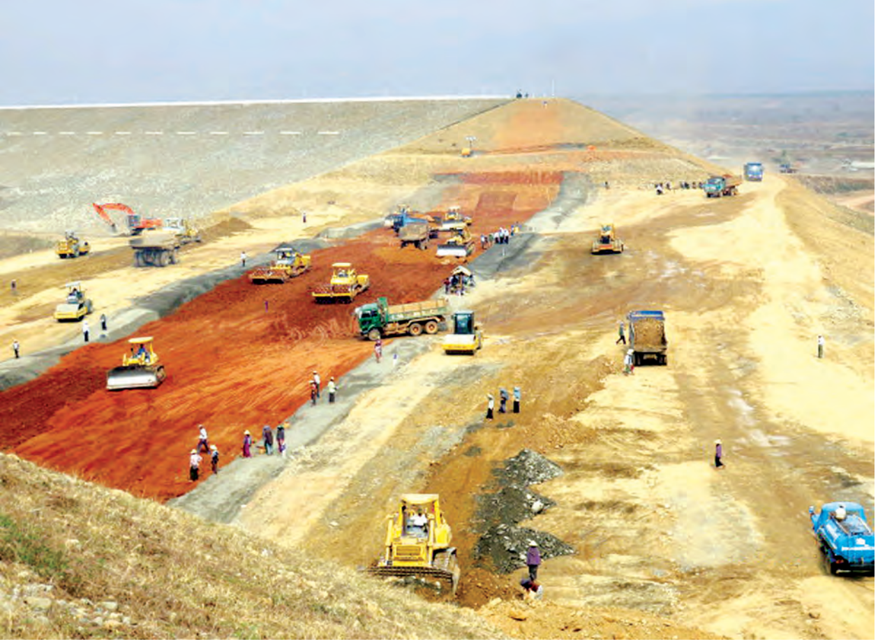
ရာဇဂြိုဟ်ဆည် တည်ဆောက်ရေး လုပ်ငန်းခွင်၌ လုပ်ငန်းများဆောင်ရွက်နေမှုကိုတွေ့ရစဉ်။
