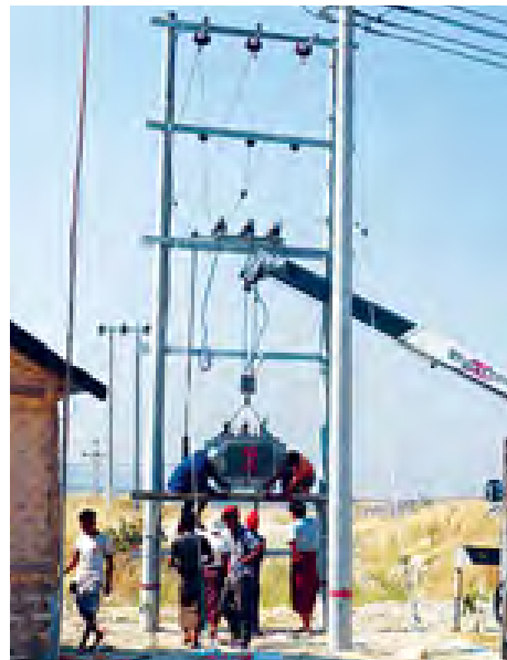
နေပြည်တော်ကောင်စီနယ်မြေ ပုဗ္ဗသီရိမြို့နယ် ဥတ္တရရေရိုင် အထွေထွေအုပ်ချုပ်ရေးဦးစီးဌာန စုပေါင်း ရုံးဝင်းအတွင်း မတ် ၃ ရက်က ခရိုင်ဌာနဆိုင်ရာရုံးများ လျှပ်စစ်အား ပိုမိုကောင်းမွန်စွာ အသုံးပြုစေနိုင်ရေး အတွက် မြို့နယ်လျှပ်စစ်ဝန်ထမ်းများက ၁၀၀ (KVA)ရှိ ထရန်စဖော်မာ တစ်လုံးကို တပ်ဆင်နေစဉ်။ (၄၀၆)
