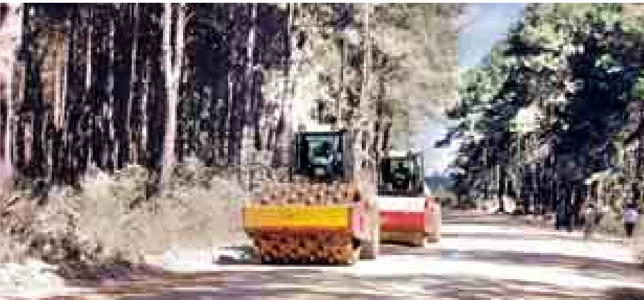
ပြင်ဦးလွင်မြို့ရှောင်လမ်းကို စက်ကြီးများဖြင့်မြေညှိလမ်းကြိုတင် ဆောင်ရွက်နေစဉ်။
