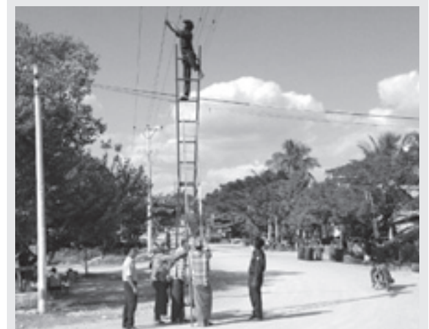
စစ်ကိုင်းတိုင်းဒေသကြီး ရွှေဘိုခရိုင် ခင်ဦးမြို့တွင် လျှပ်စစ်အန္တရာယ်ကင်းရှင်းရေးအတွက် လမ်းကျော် (၄၀၀)မီ. စာတံအားလှိုင်းများတွင် ကြိုးပြတ်ကျပါက စာတံလိုက်ခံရမှုမှ ကာကွယ်နိုင်သည့် လိုင်းချိတ်ဆက်ကြိုး (Line Link Connection)များကို မြို့နယ်လျှပ်စစ် အင်ဂျင်နီယာရုံး လိုင်းဝန်ထမ်းများက ဒီဇင်ဘာ ၂ ရက်က တပ်ဆင်နေစဉ်။ ခင်ဦးစိုးဝေ
