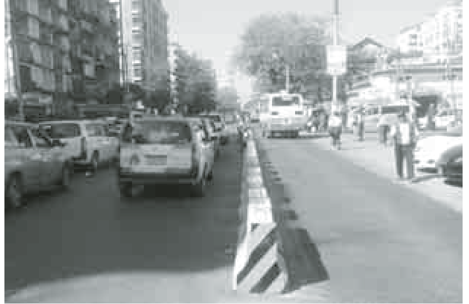
အနော်ရထာလမ်းမကြီးပေါ် လမ်း (၅၀) မှတ်တိုင်၌ ဘတ်စ်ကားသီးသန့်လမ်းကြော ဆောင်ရွက်ထားစဉ်။
