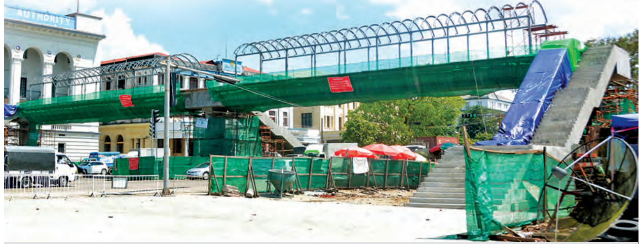
ရန်ကုန်မြို့၏ ပထမဦးဆုံး စက်လှေကားနှစ်စင်းပါ ပန်းဆိုးတန်းလူကူးခုံးကျော်တံတား တည်ဆောက်ပြီးစီးမှုကို တွေ့ရစဉ်။ ဓာတ်ပုံ-မင်းထက်
