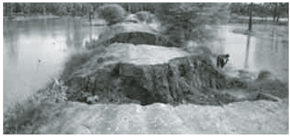
ရေစကြို-တမာတန်း မြေသားတာပေါင် ကျိုးပေါက်နေမှုကိုတွေ့ရစဉ်။
