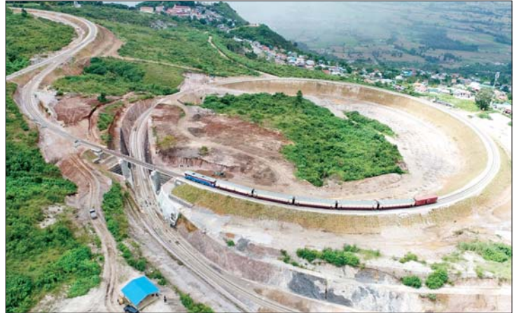
တောင်ကြီး-ရွှေညောင် ရထားလမ်းအဆင့်မြှင့်တင်ခြင်းလုပ်ငန်းမှ ထိသိမ် အပိုင်းပတ်အား တည်ဆောက်ထားမှုမှတ်တမ်း။
