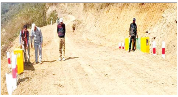
ဖောက်လုပ်ခြင်းနှင့် ၎င်းလမ်းပေါ်၌ Box Culvert လေးစင်း တည်ဆောက်ခြင်းလုပ်ငန်းများကို ၂၀၂၃-၂၀၂၄ ဘဏ္ဍာနှစ် နယ်စပ်ဒေသဖွံ့ဖြိုးရေး ပြည်ထောင်စု
