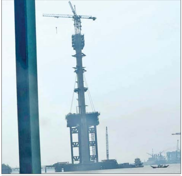
ဒလ-ရန်ကုန်တံတားကြီး၏ ဒလဘက်ခြမ်းတိုင်၌ ကြီးဆိုင်း တပ်ဆင်ထားသည်ကို တွေ့ရစဉ်။
