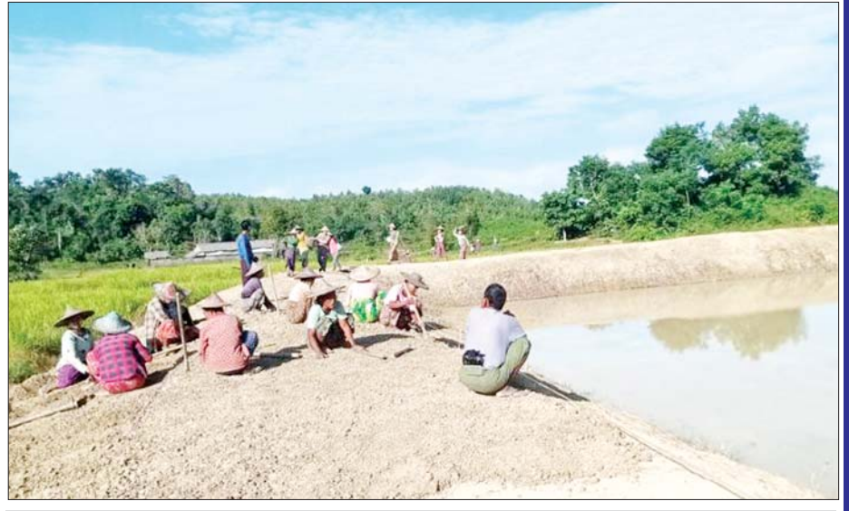
မင်းပြားမြို့နယ် ချော်ချောင်းကျေးရွာ သောက်သုံးရေကန် တာပေါင်မြှင့်တင်ခြင်းလုပ်ငန်း ဆောင်ရွက်ပြီးစီးမှုကို တွေ့ရစဉ်။
