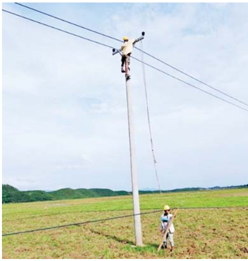
ရခိုင်ပြည်နယ် မင်းပြားမြို့နယ်၌ မိုခါမုန်တိုင်းဒဏ်ကြောင့် ပျက်စီးသွားသည့် ရွှေတမာကျေးရွာရှိ ၁၁ ကေစီ ဓာတ်အားလိုင်းနှင့် ၄၀၀ ဗို့လိုင်း ပြုပြင်ခြင်းလုပ်ငန်းများ ဆောင်ရွက်နေစဉ်။
