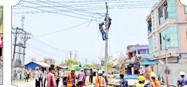
ရသေ့တောင်မြို့၌ လျှပ်စစ်ဓာတ်အားလိုင်း ပြင်ဆင်ဆောင်ရွက် နေမှုကို တွေ့ရစဉ်။
