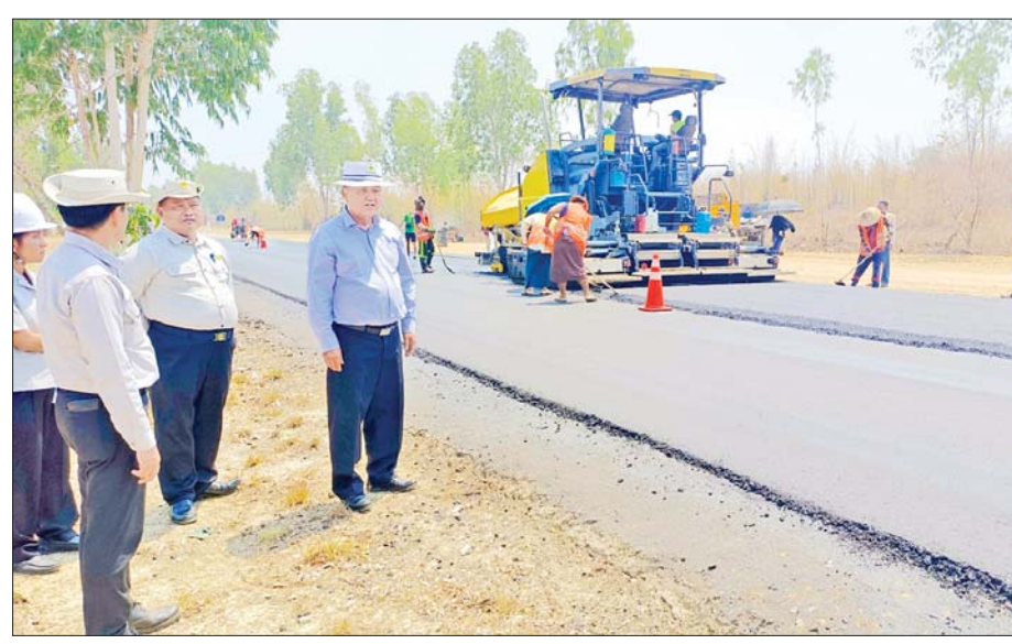
Shoulder ခင်းခြင်း ဆောင်ရွက်နေမှုများကို ကြည့်ရှု စစ်ဆေးရာ အမြန်လမ်းမကြီးထိန်းသိမ်းပြုပြင်ရေး နှင့် ကြီးကြပ်ရေးအဖွဲ့မှ ညွှန်ကြားရေးမှူး (မြို့ပြ) ဦးကျော်မိုးဦးနှင့် တာဝန်ခံအင်ဂျင်နီယာများက လုပ်ငန်းဆောင်ရွက်နေမှုများကို လိုက်လံရှင်းလင်း တင်ပြကြရာ ဒုတိယဝန်ကြီးက လုပ်ငန်းဆောင်ရွက် ရာတွင် AC ကတ္တရာလမ်းနှုတ်ခမ်းသားများကို ယာဉ်မတော်တဆမှု အန္တရာယ်ကင်းရှင်းစေရေး အတွက် သပ်ရပ်ဖြောင့်တန်းစွာဂရုပြုဆောင်ရွက်ရေး၊ သတ်မှတ်စံချိန်စံညွှန်းများနှင့်အညီ ဖြစ်စေရေး အလေးထားဆောင်ရွက်သွားရန် မှာကြားခဲ့ကြောင်း သိရသည်။ သတင်းစဉ်
