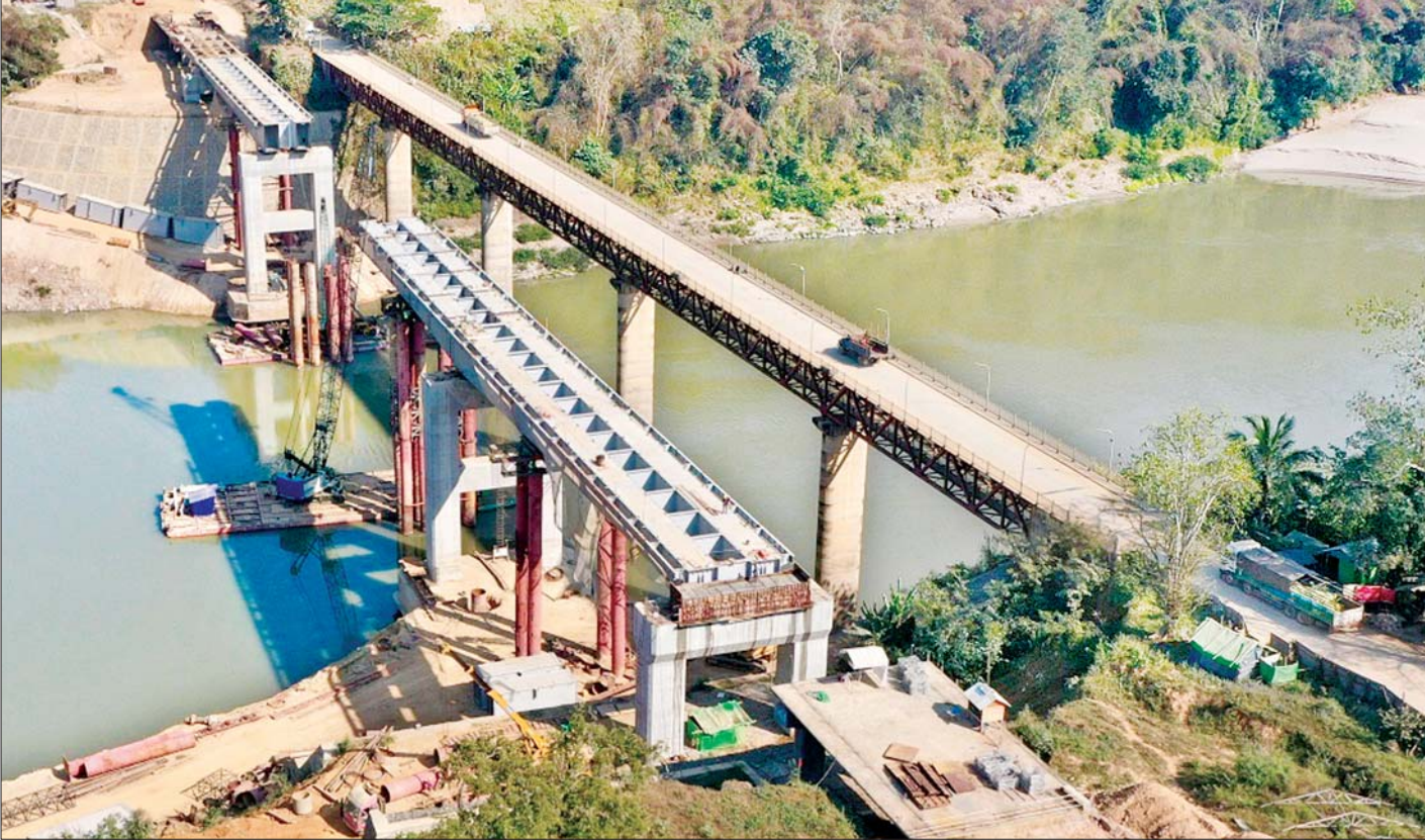
သံလွင်တံတားသစ်(တာကော်)တည်ဆောက်ပြီးစီးနေမှုကို တွေ့ရစဉ်။
