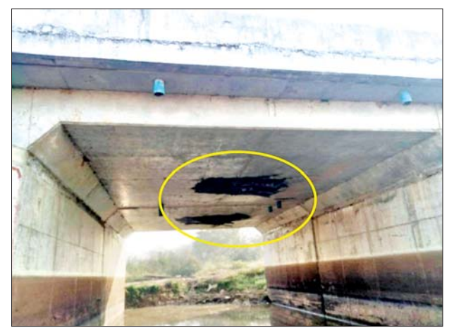
မိုင်းဖောက်ခွဲခံရမှုကြောင့် ရန်ကုန်-မန္တလေးရထားလမ်းပိုင်း ပိန်းဇလုပ်နှင့် ကျောက်တံခါးဘူတာအကြား တံတားအမှတ်(၁၄၅) ကြမ်းခင်းပျက်စီးဆုံးရှုံးမှုအခြေအနေ။
