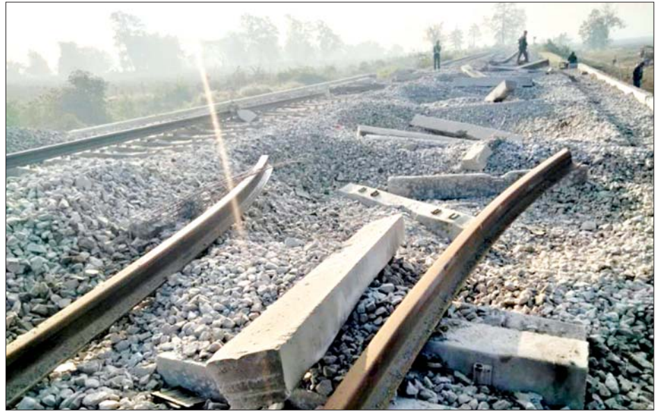
မိုင်းဖောက်ခွဲခံရမှုကြောင့် ရန်ကုန်-မန္တလေးရထားလမ်းပိုင်း ပိန်းဇလုပ်နှင့် ကျောက်တံခါးဘူတာအကြား တံတားအမှတ်(၁၄၅)ပေါ်တွင် ရထားလမ်းပျက်စီးဆုံးရှုံးမှုအခြေအနေ။
