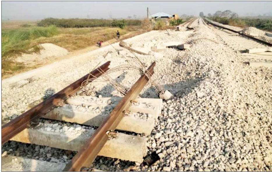
မိုင်းဖောက်ခွဲခံရမှုကြောင့် ရန်ကုန်-မန္တလေးရထားလမ်းပိုင်း ပိန်းဇလုပ်နှင့် ကျောက်တံခါးဘူတာအကြား တံတားအမှတ်(၁၄၅)ပေါ်တွင် ရထားလမ်းပျက်စီးဆုံးရှုံးမှုအခြေအနေ။
