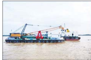
မြေတူး-၂ ရေယာဉ်(26M Grab Dredger)
