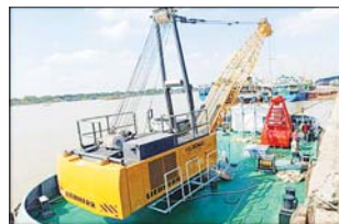
မြေတူး-၃ ရေယာဉ်(25M Grab Dredger)
