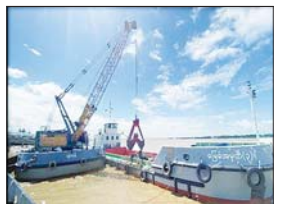
မြေခဲ-၃ ရေယာဉ် (170 m3 Split Hopper barge)
