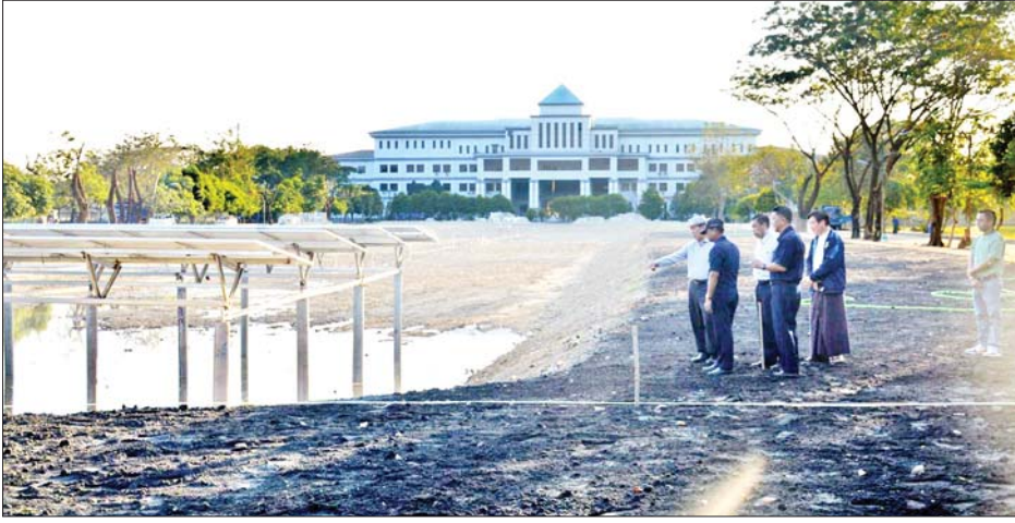
ဦးဗိုလ်ဌေးအဖွဲ့အစည်းအဖွဲ့အစည်းများကို ကြည့်ရှုစစ်ဆေးပြီး လိုအပ် စက်ယန္တရားများဖြင့် ရေမြောင်းတူးဖော်နေမှုကို ဆက်လက်၍ မြို့တော်ဝန်နှင့်အဖွဲ့သည် လည်းကောင်း၊ ထိန်းပင်နောက်ဆုံးစွန့်ပစ်အမှိုက်ပုံ
